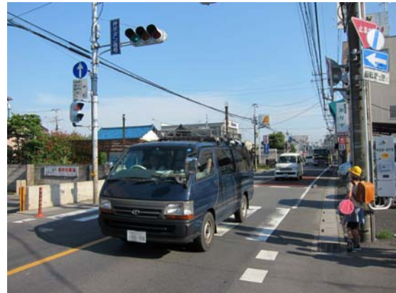
歩道の整備が必要な道路
