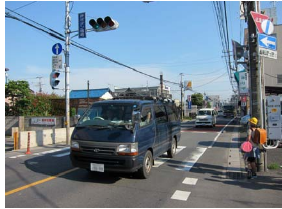
歩道の整備が必要な道路
