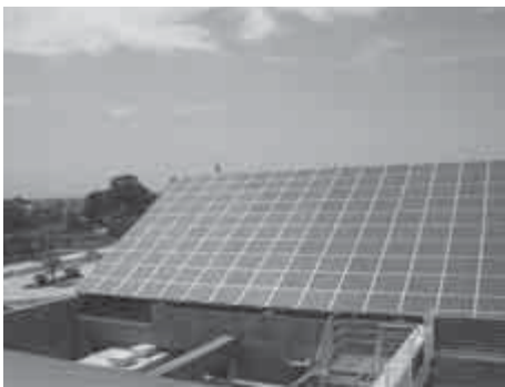
太陽光パネル
