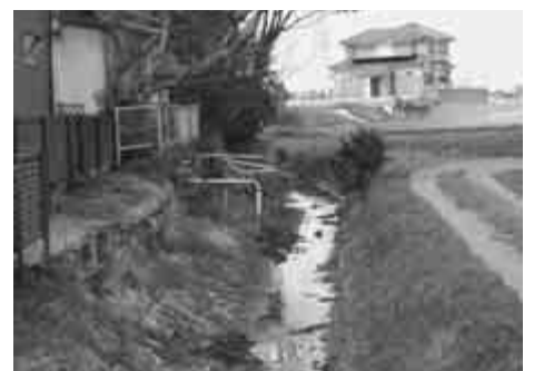
—深井新田・平方新田排水路—
