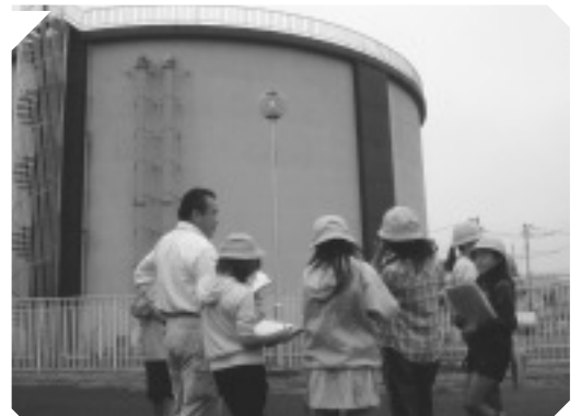
配水池：県から送られてきた水やろ過された水をいったんためて各家庭へ配水します 関小（会野谷浄水場）
