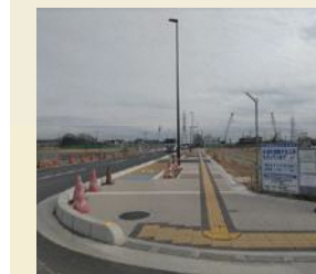
舗装された道路
