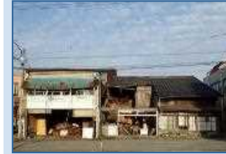
空き家の除却
