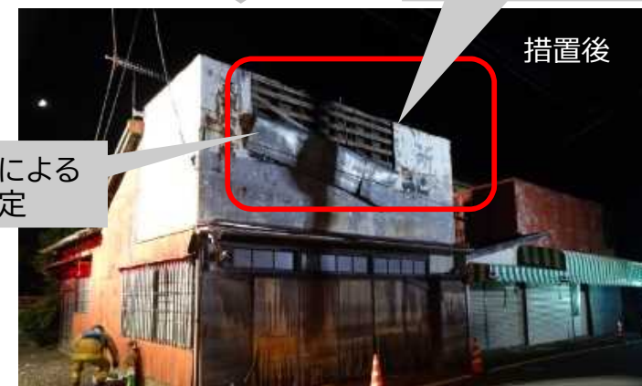
外壁の一部切断
