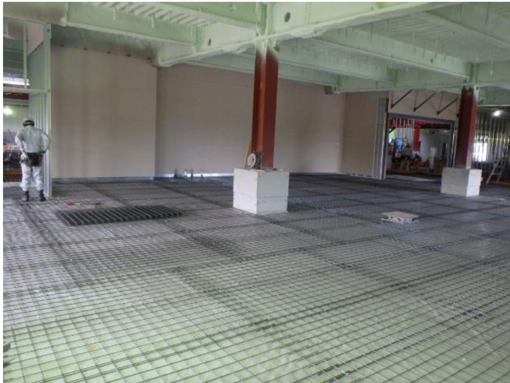
■ 2015年9月末 工事状況写真(内観 床嵩上げ前)
