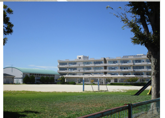
▲令和 5 年（2023）現在の校舎外観
