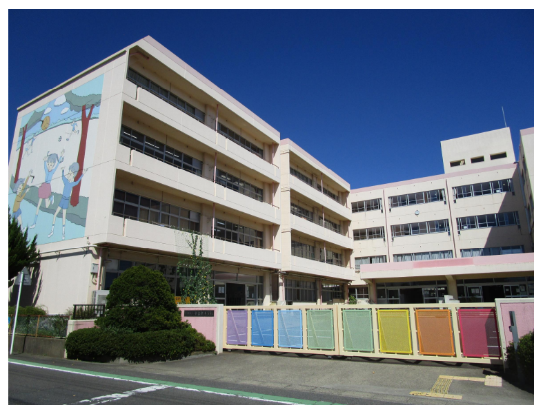
▲令和5年（2023）現在の校舎外観
