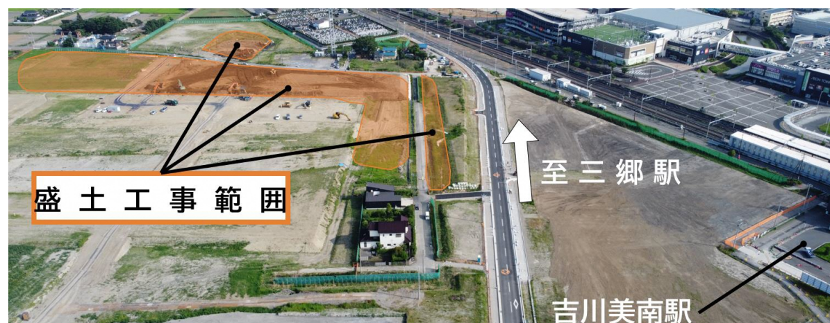
<写真:C 近隣公園南側の盛土工事>
