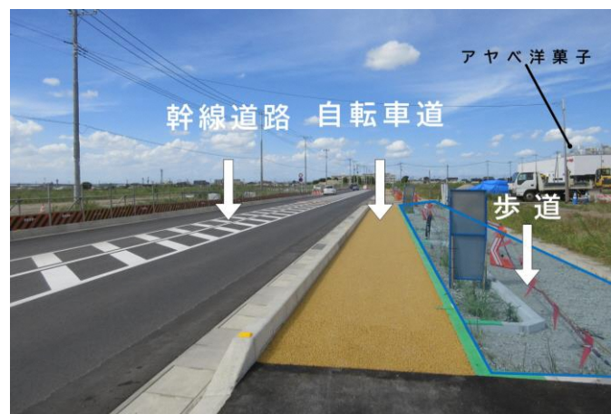
<写真:B 幹線道路沿いの歩道舗装工事>
