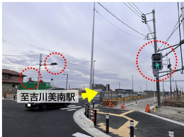
<写真A 県道部新設信号機>
