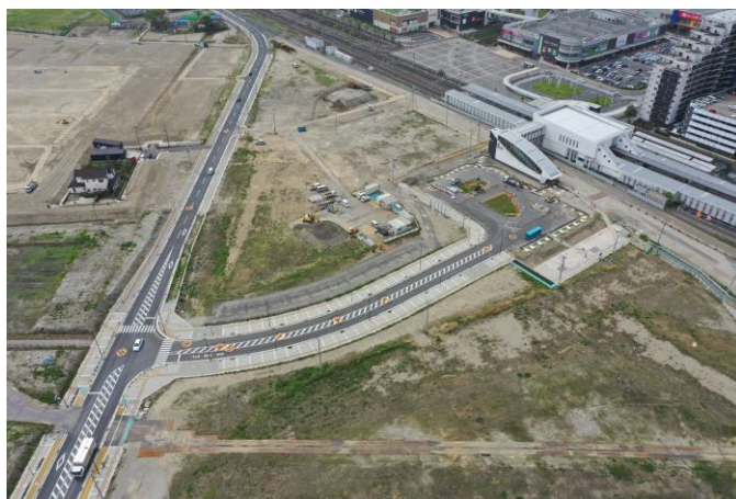
<写真B 駅前広場工事>
