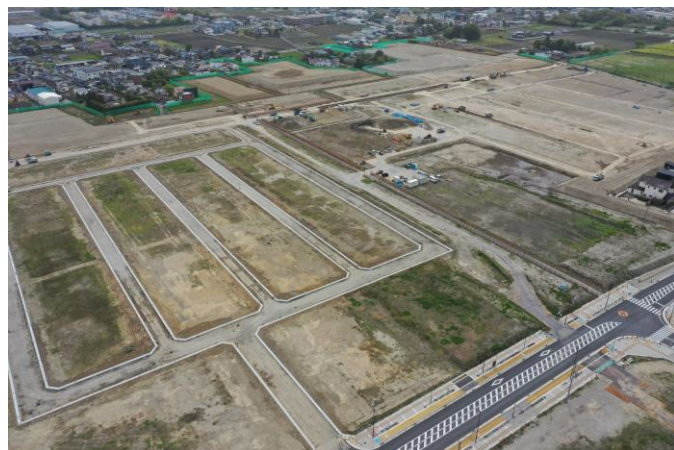
<写真C 区画道路工事>
