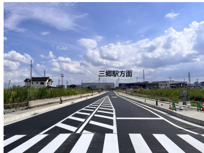
<写真 C 道路舗装工事>
