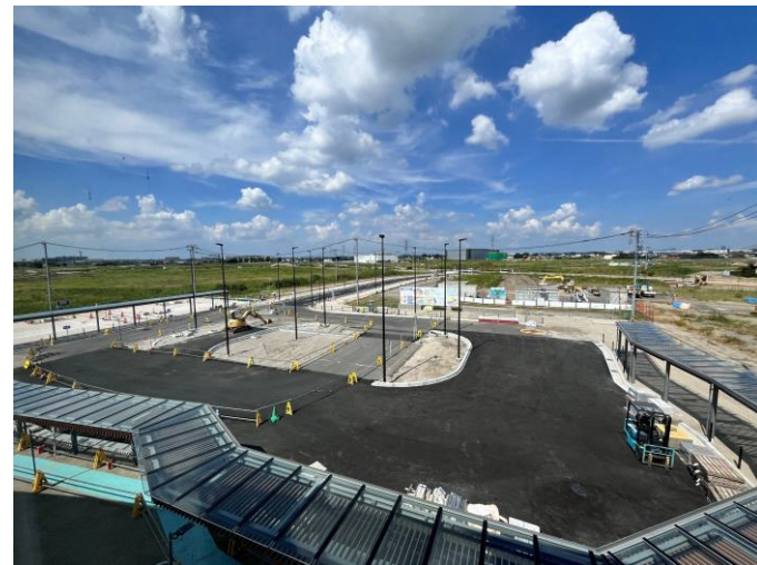
<写真 A 駅前広場工事>
