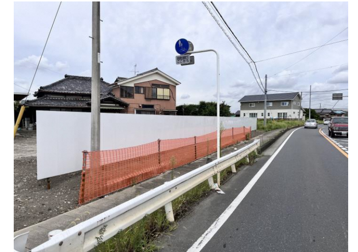
<写真 A 対象物件の移転・撤去の状況>
