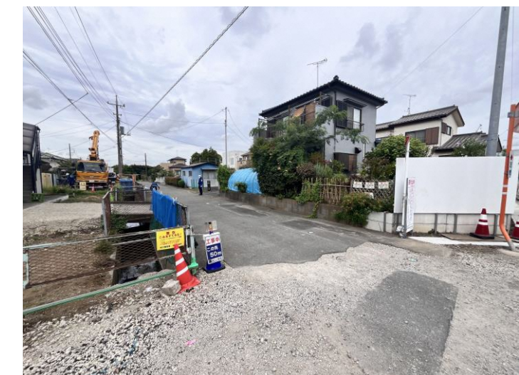
<写真 C 対象物件の移転・撤去の状況>
