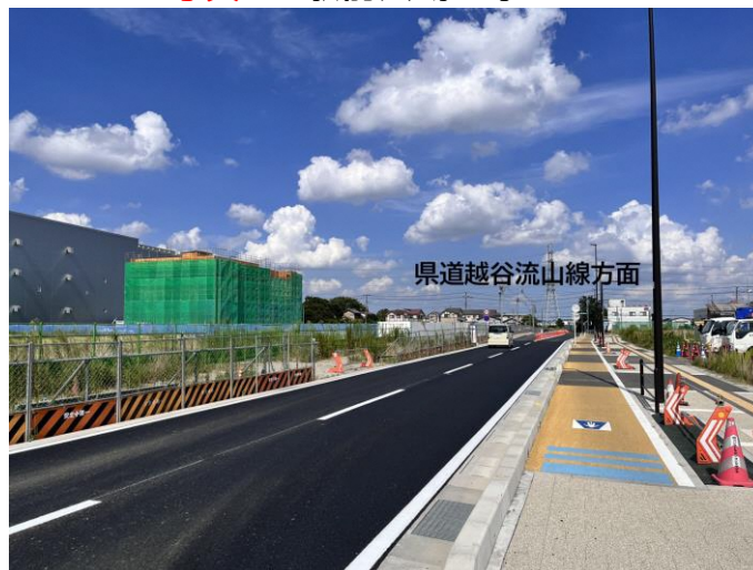
<写真 D 道路舗装工事>
