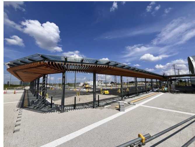
<写真 B 駅前広場工事>
