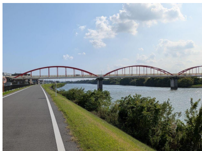
新中川水管橋
