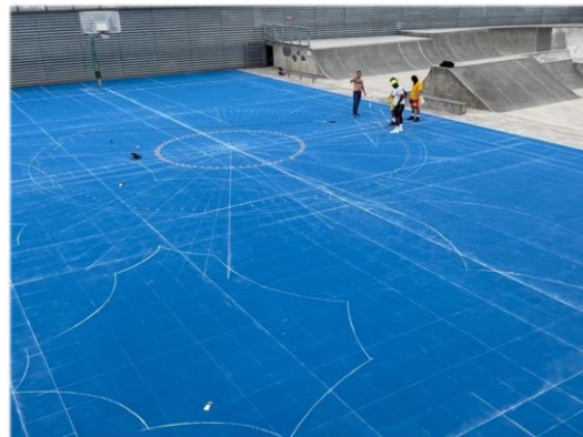
リノベーション作業の様子
