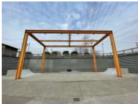
完成したセクション
