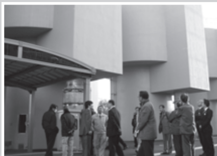
オゾン接触池
