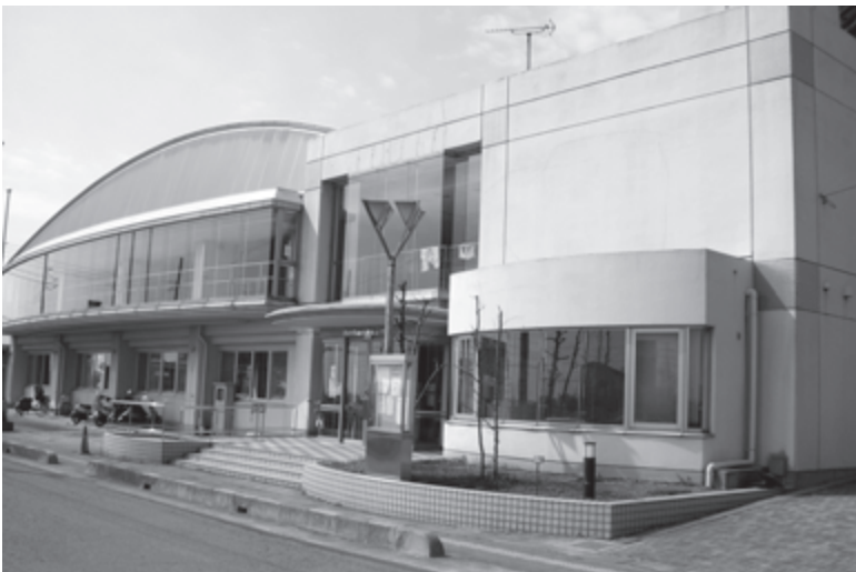
屋内温水プール
