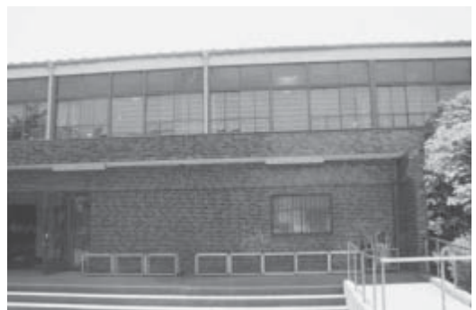
南中学校体育館
