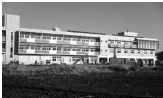
完成が間近となる美南小学校
