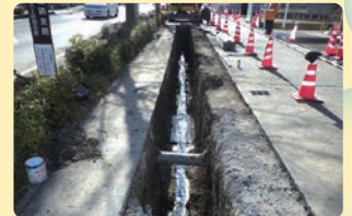
耐震管への更新
