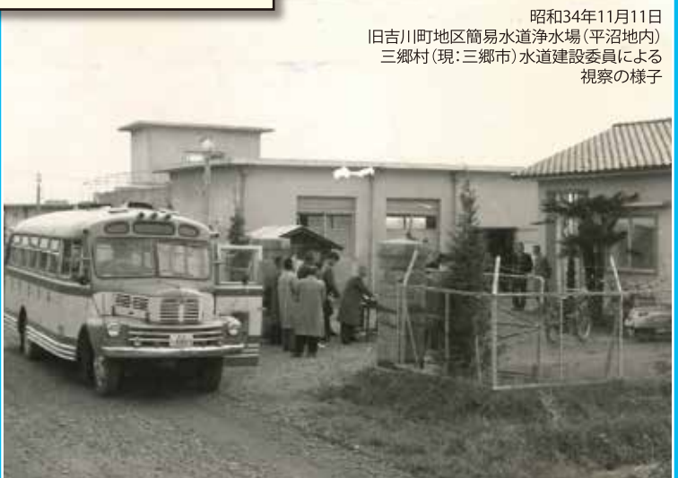
昭和35年1月 広域簡易水道(第2浄水場 会野谷地内)
