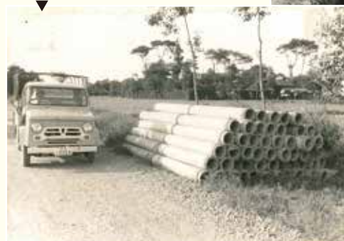
昭和36年 中井地区に集積された配水管
