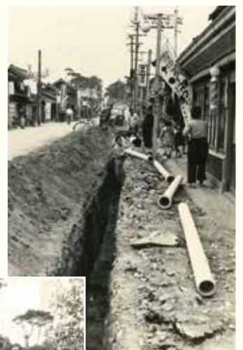
昭和32~34年頃の平沼地内の配水管布設工事の様子
