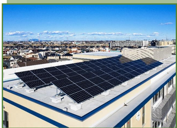
吉川中学校屋上の太陽光発電設備
