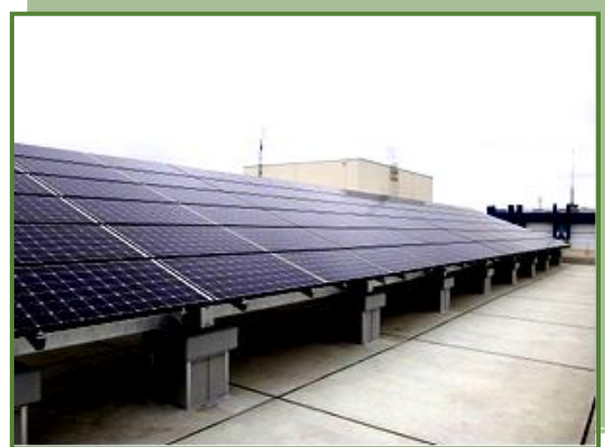
会野谷浄水場屋上の太陽光発電設備
