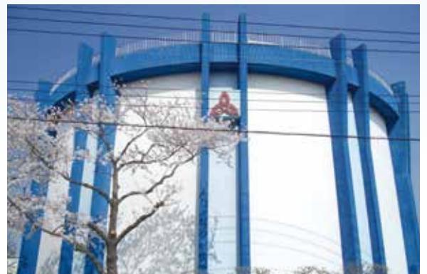
会野谷浄水場 No.2 PC タンク
