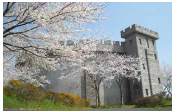
南配水場 PC タンク
