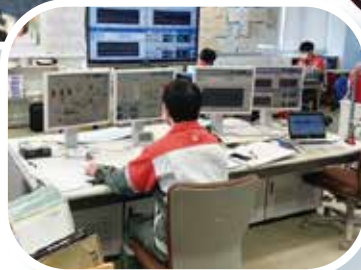
水道施設の運転状況をモニターにて監視している様子
