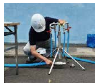
②応急給水栓組立
