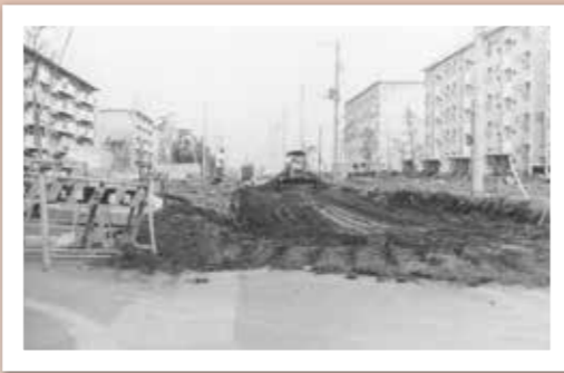
昭和48(1973)年 完成間近の吉川団地
