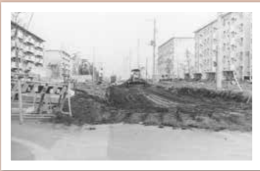
昭和48(1973)年 完成間近の吉川団地
