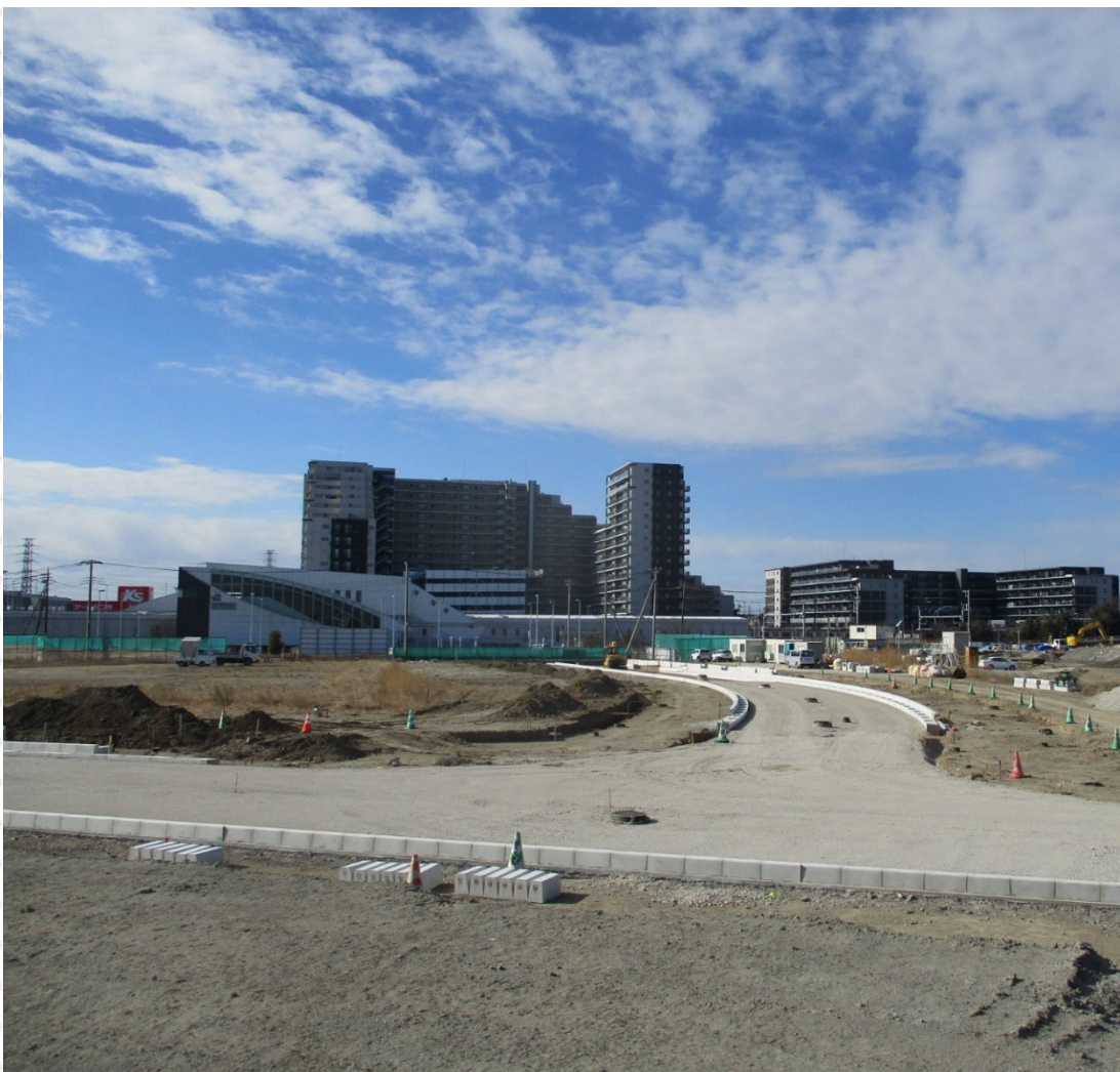
開発中の吉川美南駅東口周辺地区
