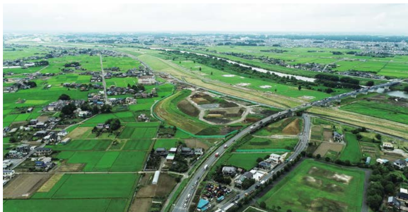
江戸川の河川改修と河川防災ステーションの整備
