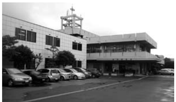
昭和43年建設の市役所。安全性は…。
