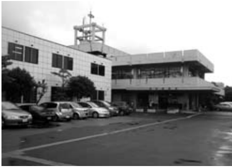
耐震性が心配される市役所庁舎
