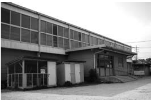
耐震補強・大規模改修工事が行われる関小体育館
