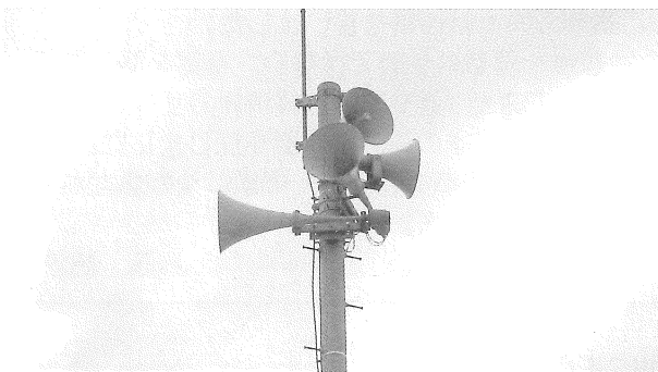
音達調査が実施される防災無線
