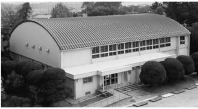
耐震工事が終了した三輪野江小体育館
