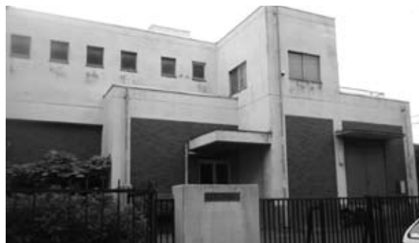
共保雨水ポンプ場
