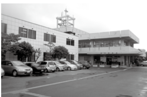
耐震性が心配される市役所庁舎
