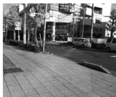
経年劣化による段差の解消を
