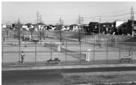
順次、修繕されるテニスコート
