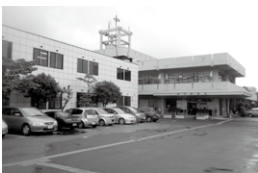
耐震性が心配される市役所庁舎
