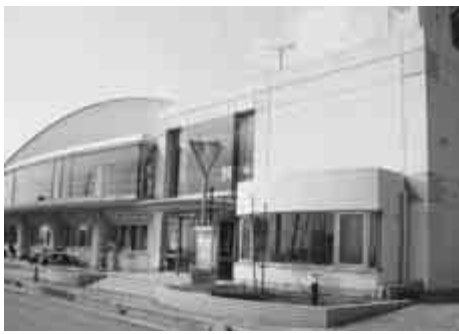
— 屋内温水プール —
