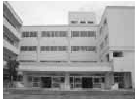
耐震補強工事が完了した中曽根小学校
