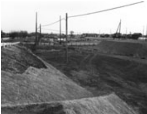
中川の堤防工事
