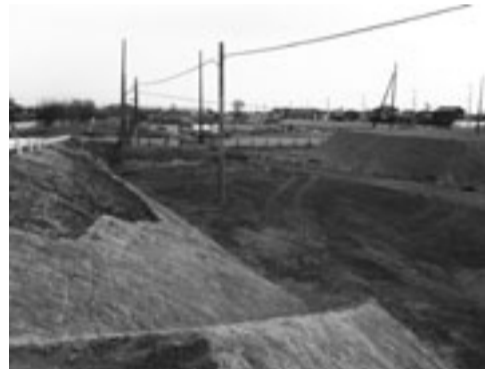
中川の堤防工事
