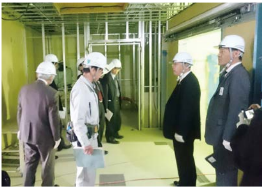
学校給食センター建設現場見学
