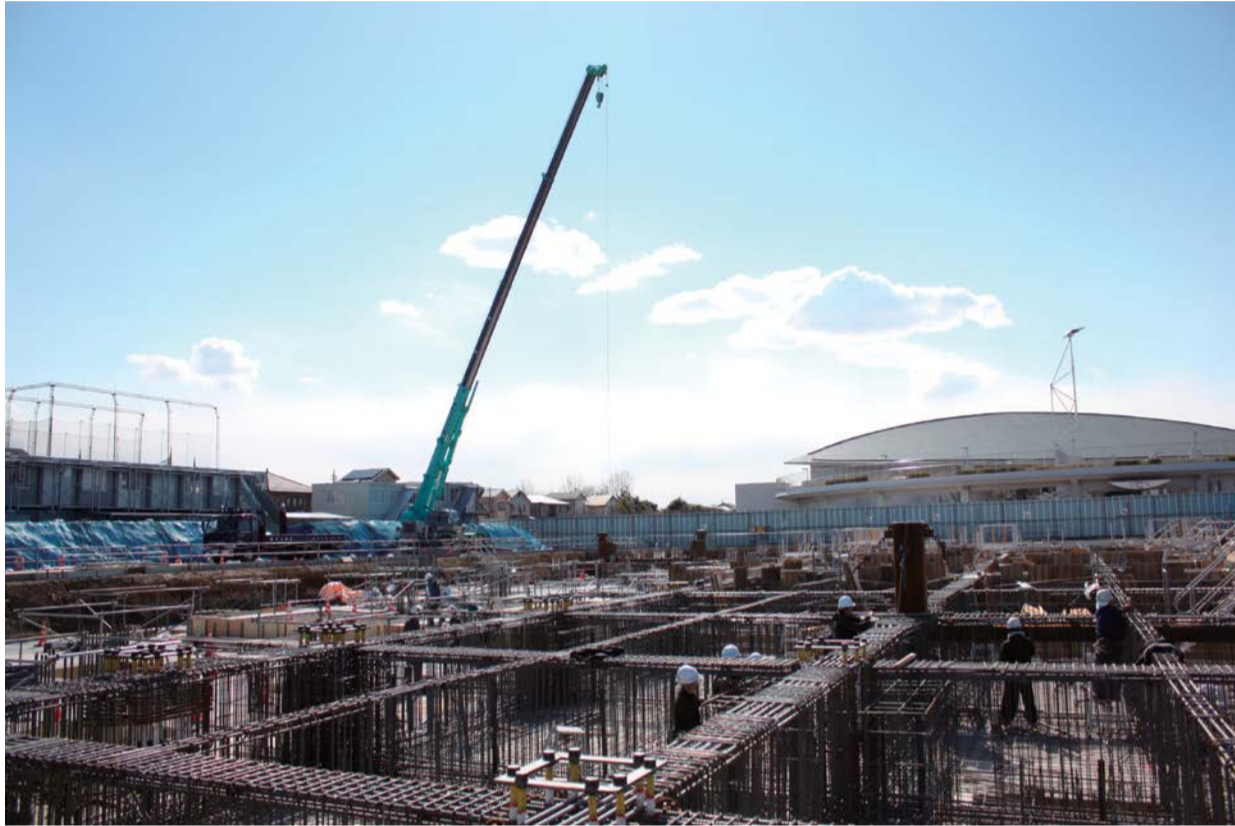
新庁舎 建設中のようす（※8ページに説明があります。）
