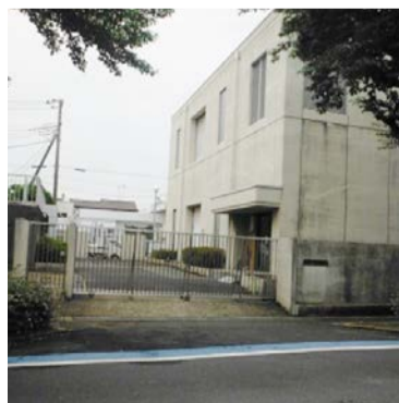
工事予定の高久ポンプ場
