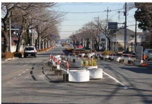
4車線になる市道2-318号
