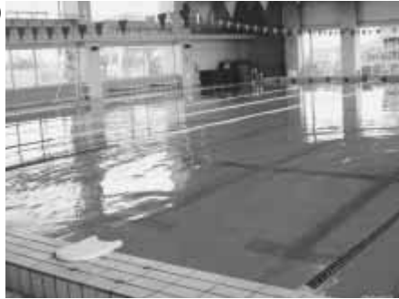
屋内温水プール
