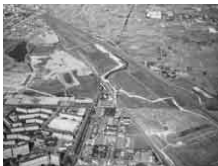
武蔵野操車場跡地
