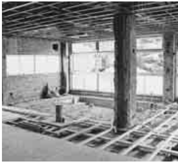
改装中の老人福祉センター
