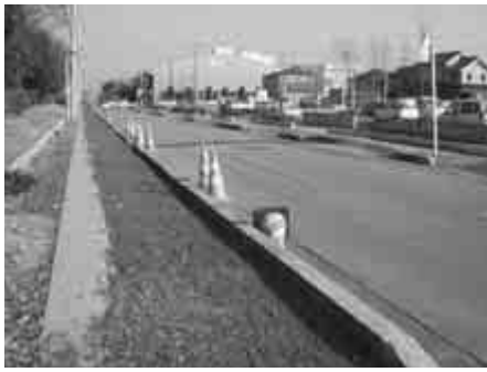
吉川団地南側の道路
